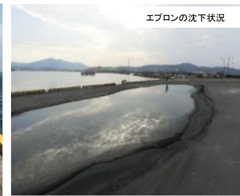
エプロンのクラック、沈下回復状況
