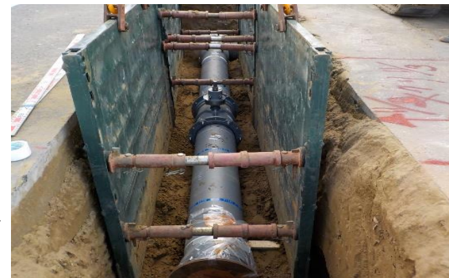
耐震管の布設工事状況
