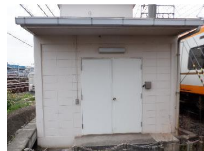
防水扉設置、外壁防水塗装
