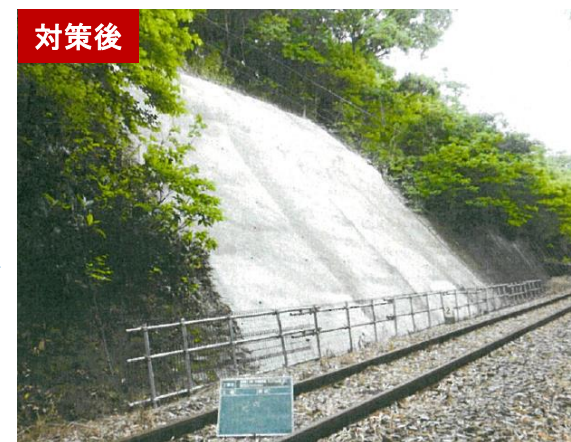
コンクリート吹付による法面固定
