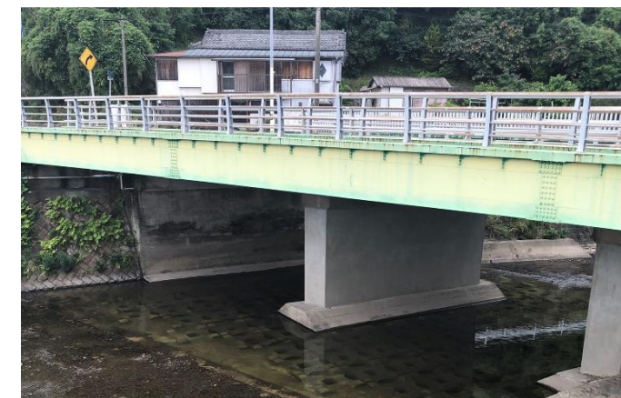
工事完成後の状況
