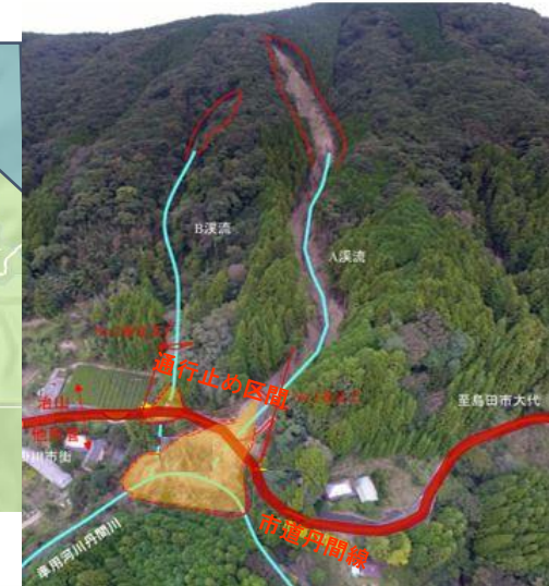
令和4年台風15号による被害の状況
