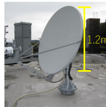
第3世代システムの衛星通信機器（アンテナ、室内機器ともに小型かつ低コスト）
