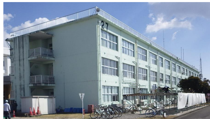
既存庁舎（S32年建設）
