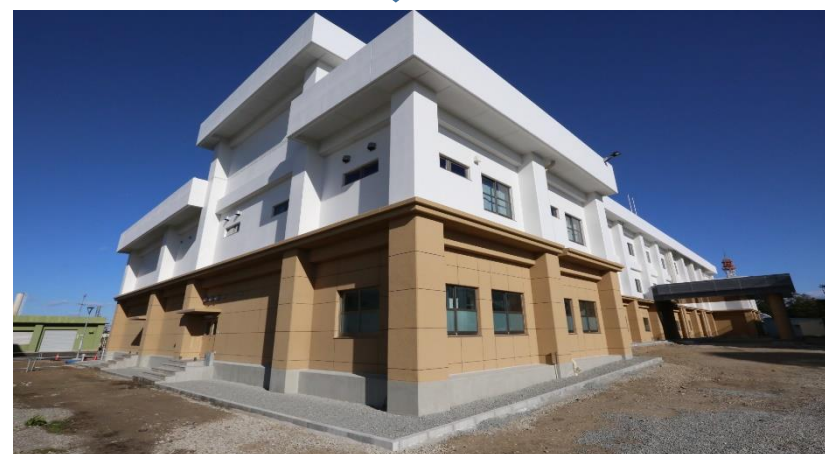
耐震性能を備えた新設庁舎（R4年度建設）
