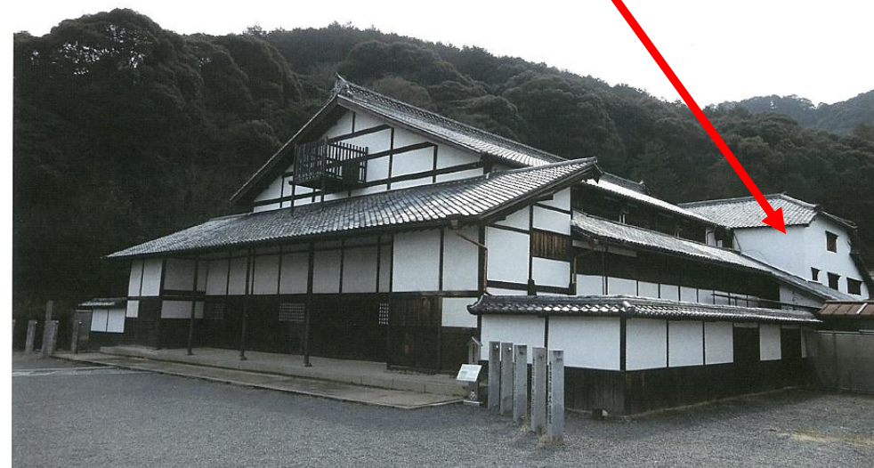
補強完了後 外観
