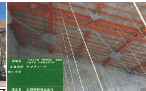
屋根のブレース補強
