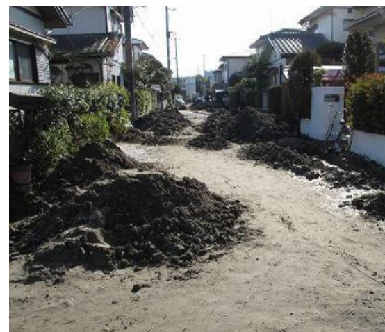
平成23年東日本大震災により発生した宅地の液状化
