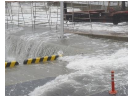
越波による浸水(平成23年台風12号)
