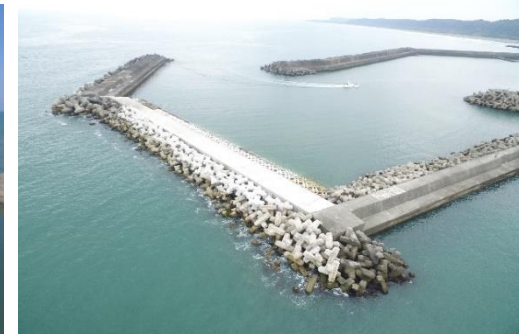
防波堤(新設、粘り強い化)
