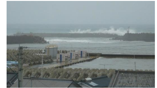
港内へ高波の進入
