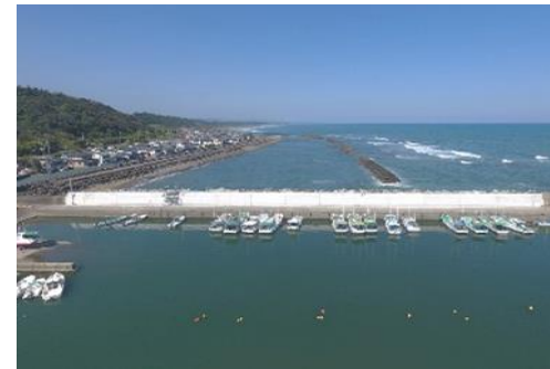
北防波護岸(改良、かさ上げ)
