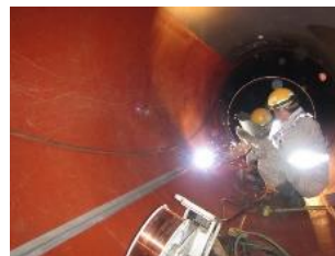
管内で鋼管を溶接
