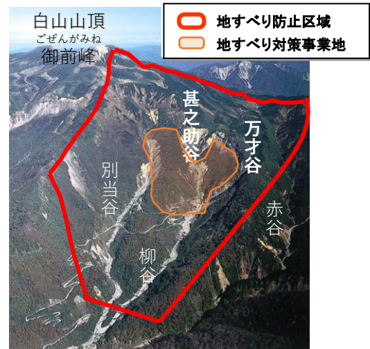
甚之助谷地区地すべり
