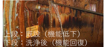
既設集水ボーリング孔の洗浄
