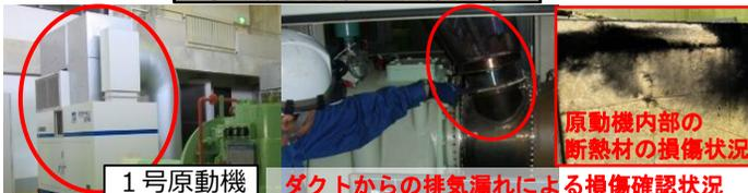
年点検の結果、原動機内部のダクトや断熱材の損傷が判明したため、原動機を分解し、損傷部分の修繕を実施した。
