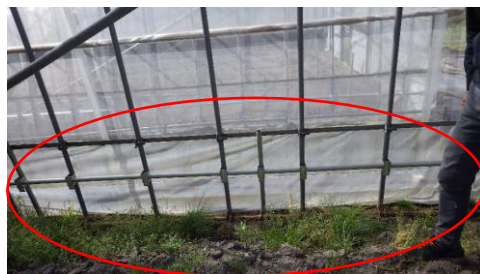
埋込パイプ、横直管パイプの追加
