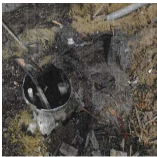
風水害による破損のリスク
