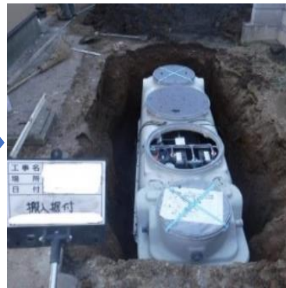
合併処理浄化槽設置
