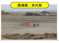
誘導路の未対策 箇所では、液状 化により舗装が沈 下し、復旧に約 1ヶ月間を要しま した。
