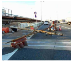
信号柱の倒壊
