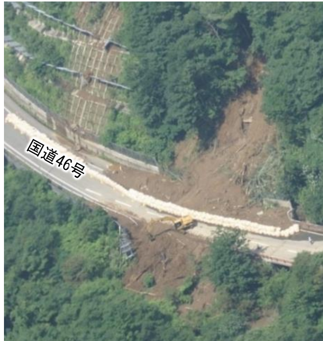
平成25年8月豪雨による被災（法面崩壊）
