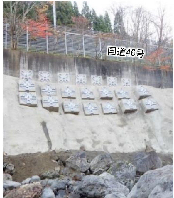
法面对策（道路の下側から撮影）
