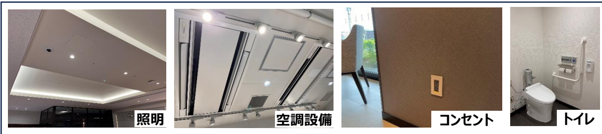
災害時に活用可能な設備（一例）
