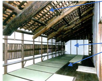
二階楽屋 補強完了後
