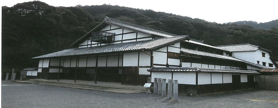
補強完了後 外観
