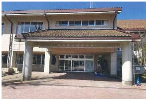
体育館の外観
