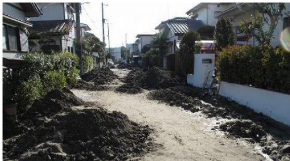
平成23年東日本大震災により発生した宅地の液状化
