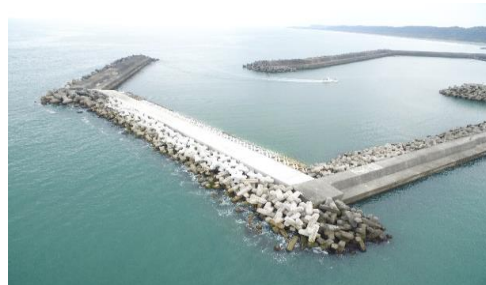
防波堤（新設、粘り強い化）
