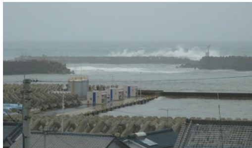
港内へ高波の進入
