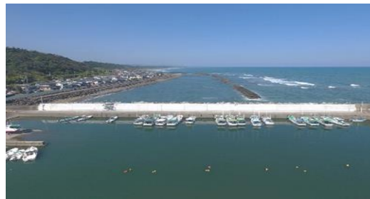
北防波護岸（改良、かさ上げ）
