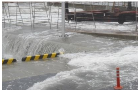
越波による浸水（平成23年台風12号）
