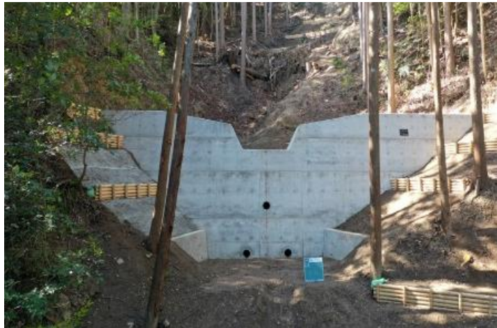
土石流等が発生するおそれがあるため、治山ダムを設置 (静岡県浜松市天竜区)
