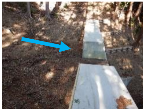
治山ダムが流出土砂を捕捉
