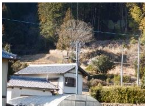
保全対象地区に被害なし
