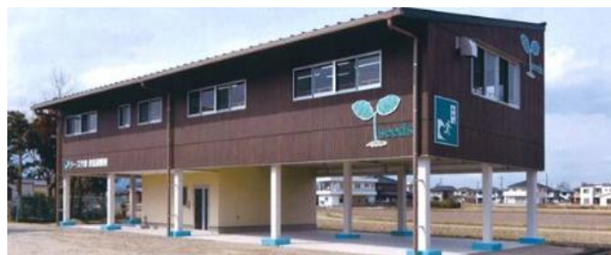
竣工した津波避難施設
