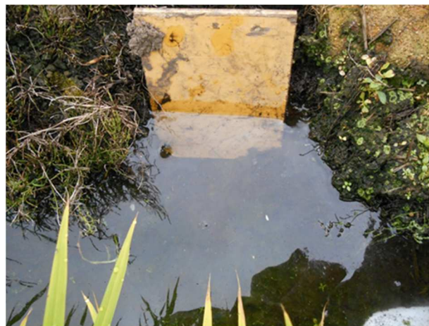
▲止水板による止水状況
