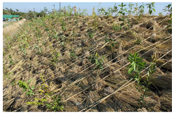
▲沿岸部の緑化と高潮時の防災対策
