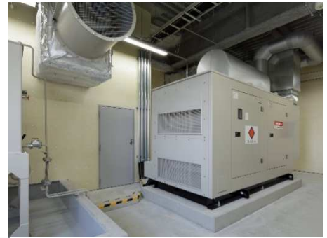
▲非常用発電機
