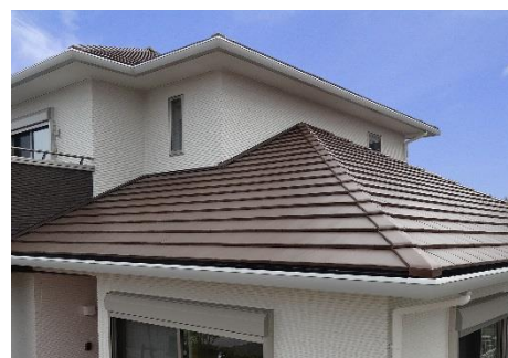
▲洋風防災瓦の施工例
