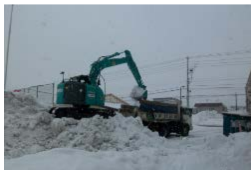
▲バックホウとダンプによる除排雪
