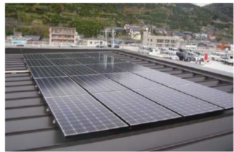
▲減災型ソーラーパネルの設置
