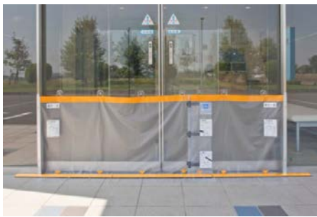
▲止水シートの設置
