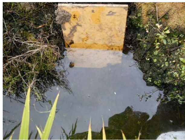
▲止水板による止水状況
