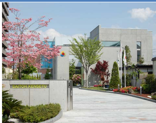
▲ 齋藤建設本社 外観
