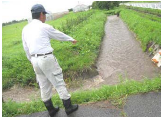
▲異常気象時（大雨時）の点検・確認
