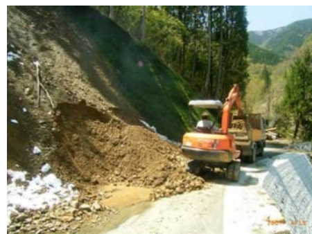
▲土砂崩れ現場での作業
