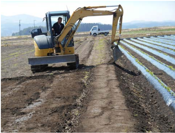
▲バックホーによる復田の畦畔高上げ
