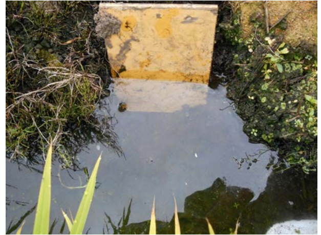
▲止水板による止水状況
