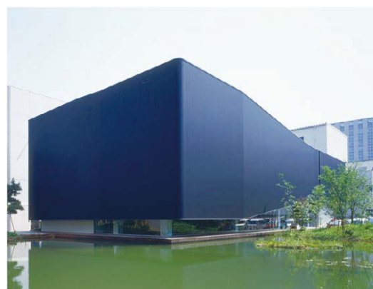
▲水の浮力を利用した世界初の免震建物である風洞実験棟
