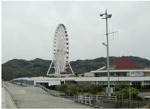
防災行政無線:拡声子局(カメラ付)の例
