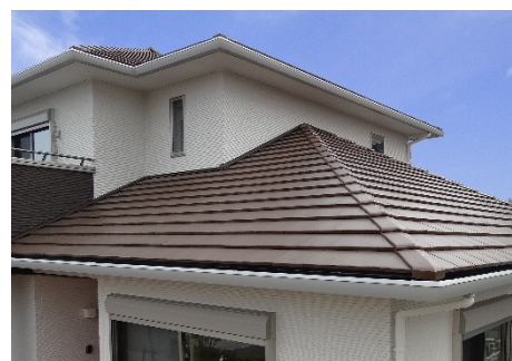
▲洋風防災瓦の施工例
