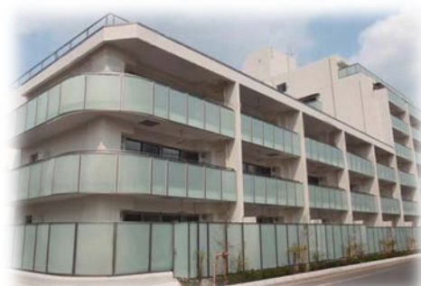
▲耐震補強工事施工後
