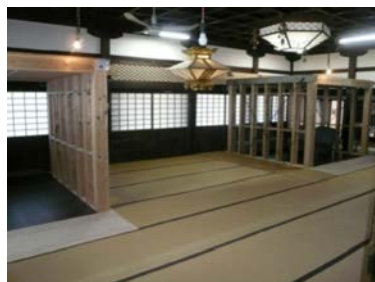
▲耐震シェルターの施工例
