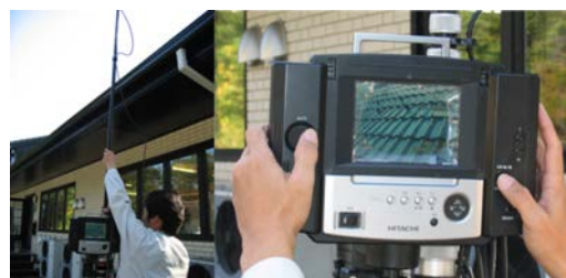
▲ポールカメラ診断の様子
