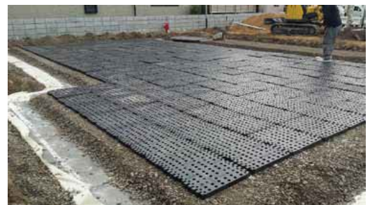
▲戸建建設時の基礎地盤で使用しているスーパージオ工法
