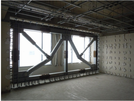
▲鉄骨の周囲にディスクシアキー設置状況
