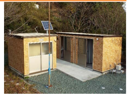
▲循環サイクルトイレ外観
