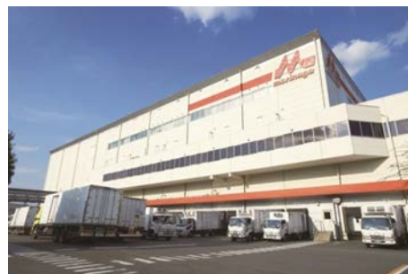
▲森永乳業 東京多摩工場
