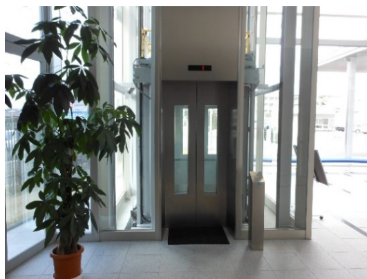
▲導入したエレベータ
