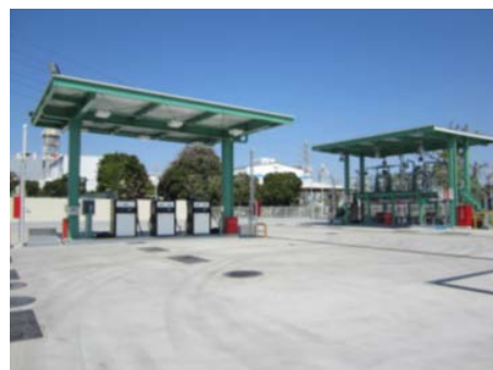
▲杉戸燃料備蓄基地の外観
