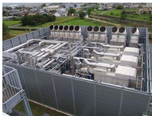
▲ガスコージェネレーション設備
