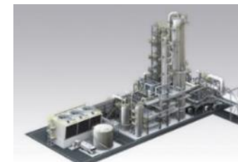
CO 2 回収プラント
