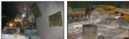
トンネルの修繕
