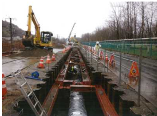
管の布設工事
