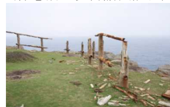
(老朽化した落下防止柵の再整備)
