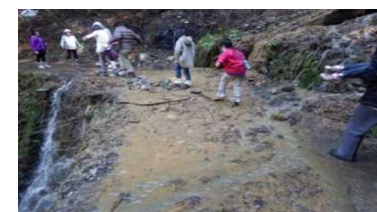
(利用が多い荒廃歩道の再整備)
