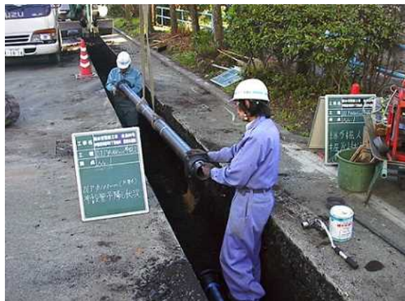
管路の布設工事
