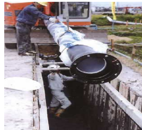
老朽管の更新工事
