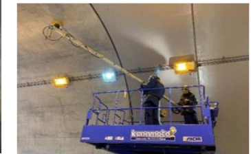
レーダーを利用した トンネル覆工の変状把握
