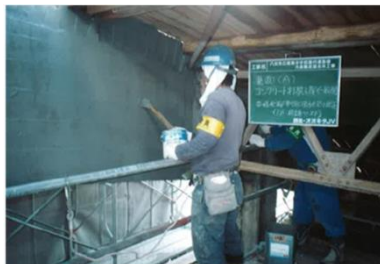
中性化対策のための抑制剤やアルカリ性付与剤の塗布
