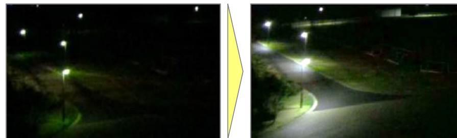
夜間の視認性確保のため照明を整備
