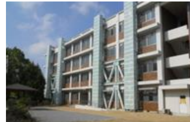
老朽改善された施設
