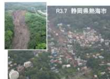
死者28名、住宅被害98棟
