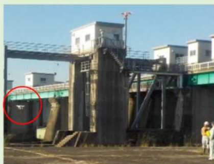
頭首工点検における UAV活用状況
