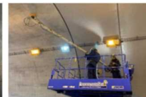
レーザーを利用した トンネル覆工の変状把握
