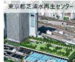
下水道(民間収益施設併設)
