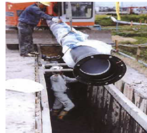
老朽管の更新工事
