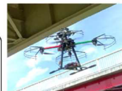
ドローンによる損傷把握
