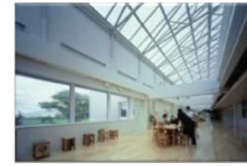
外断熱、自然光利用、自然換気などの省エネルギー化、外壁等改修
