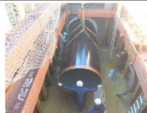
管路の耐震化工事(老朽管内に新管の挿入)
