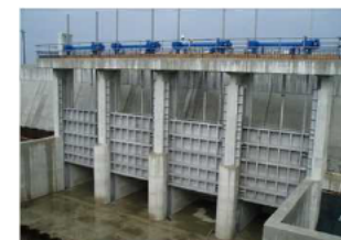
海岸保全施設(水門)
