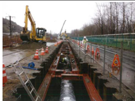
管の布設工事
