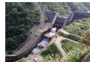
砂防施設(砂防堰堤)
