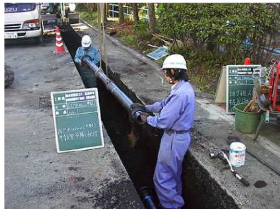
管路の布設工事
