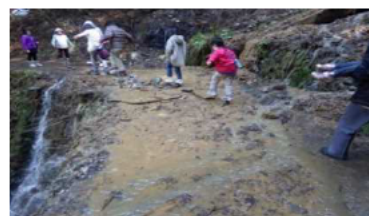
(利用が多い荒廃歩道の再整備)
