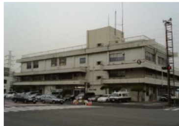
老朽化した警察施設
