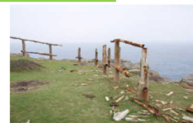
(老朽化した落下防止柵の再整備)
