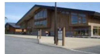
(ビジターセンターの長寿命化対策整備)
