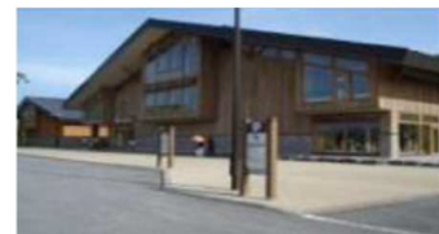
(ビジターセンターの長寿命化対策整備)
