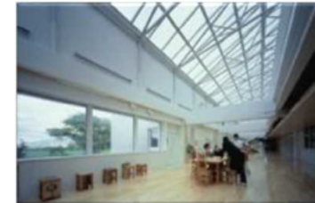
外断熱、自然光利用、自然換気などの省エネルギー化、外壁等改修
