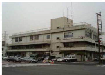
老朽化した警察施設
