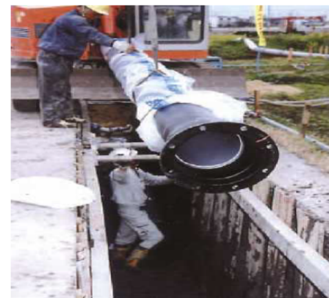
老朽管の更新工事
