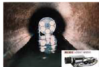
テレビカメラによる管路の点検・調査
