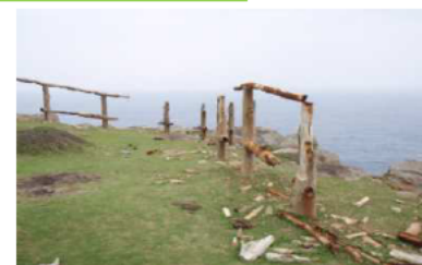
(老朽化した落下防止柵の再整備)
