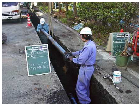
管路の布設工事
