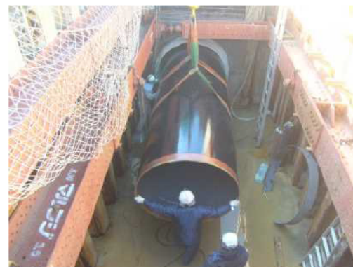
管路の更新工事(老朽管内に新管の挿入)
