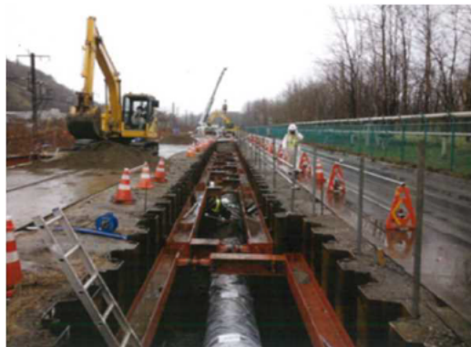
管の布設工事
