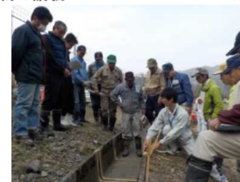
水路補修工法技術の出前授業
