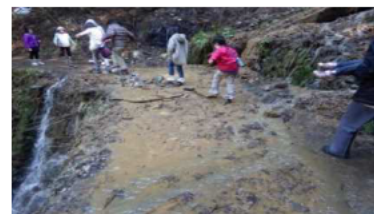
(利用が多い荒廃歩道の再整備)
