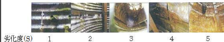
集水井の劣化度評価
