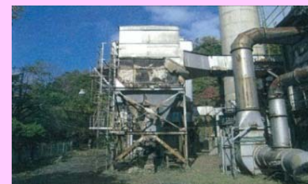
老朽化した 廃棄物処理施設
