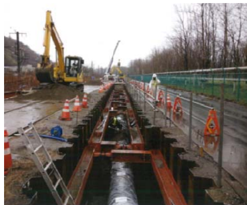
管路の布設工事
