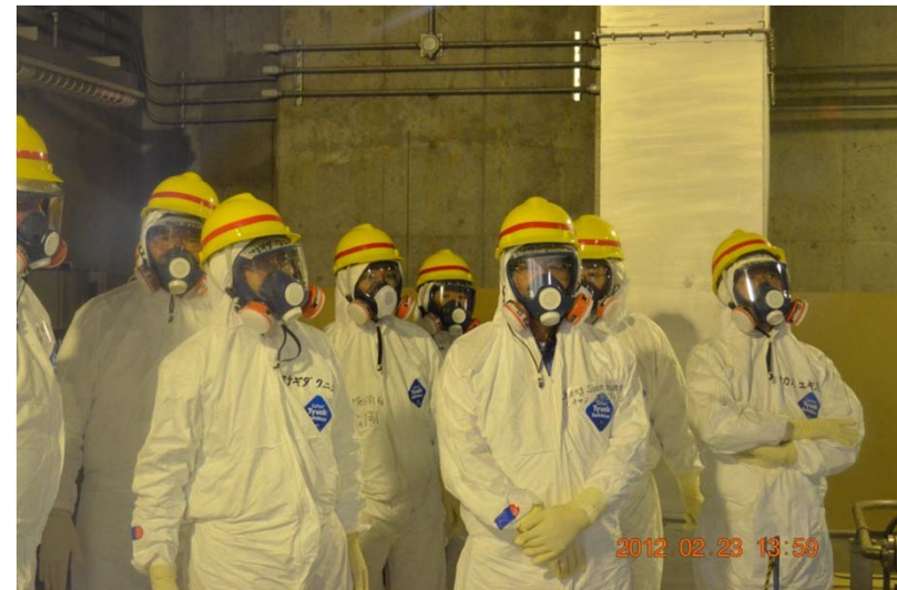
補助共用建屋 非常用ディーゼル発電機室
