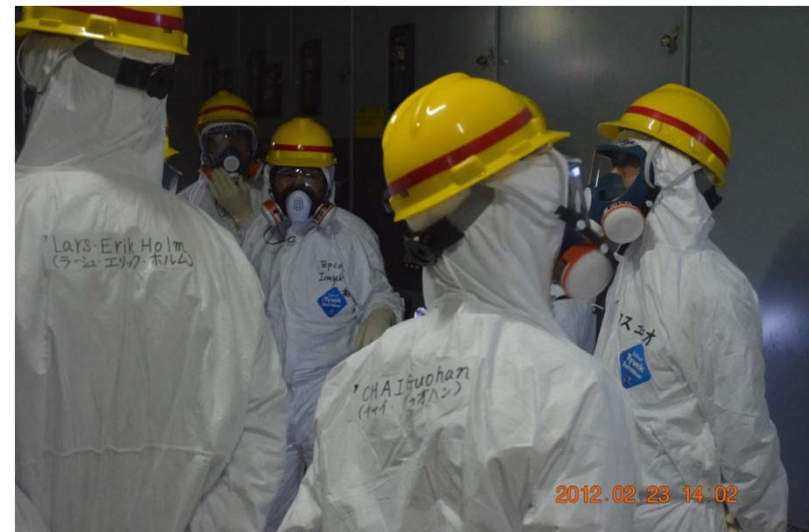
補助共用建屋 2号D/G電気品室
