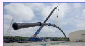
耐震管による施設の強靱化
